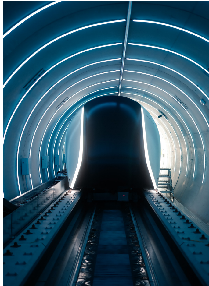
TUM Hyperloop Betonröhre mit Pod
